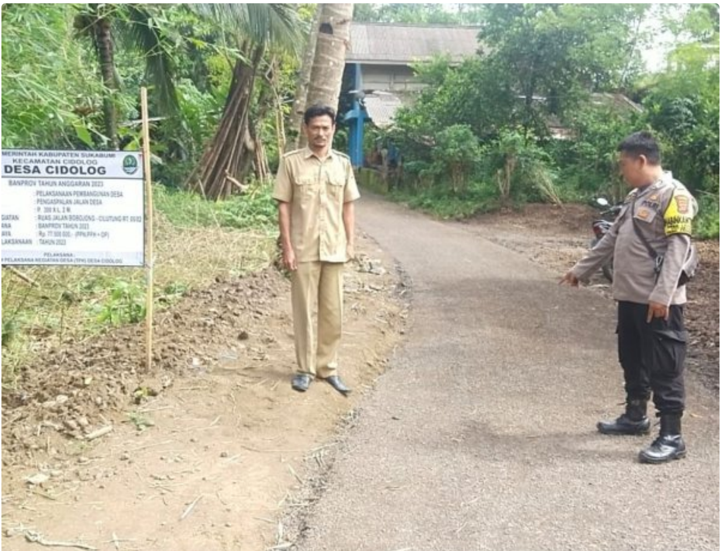
Bhabinkamtibmas Desa Cidolog Awasi Pembangunan Desa
