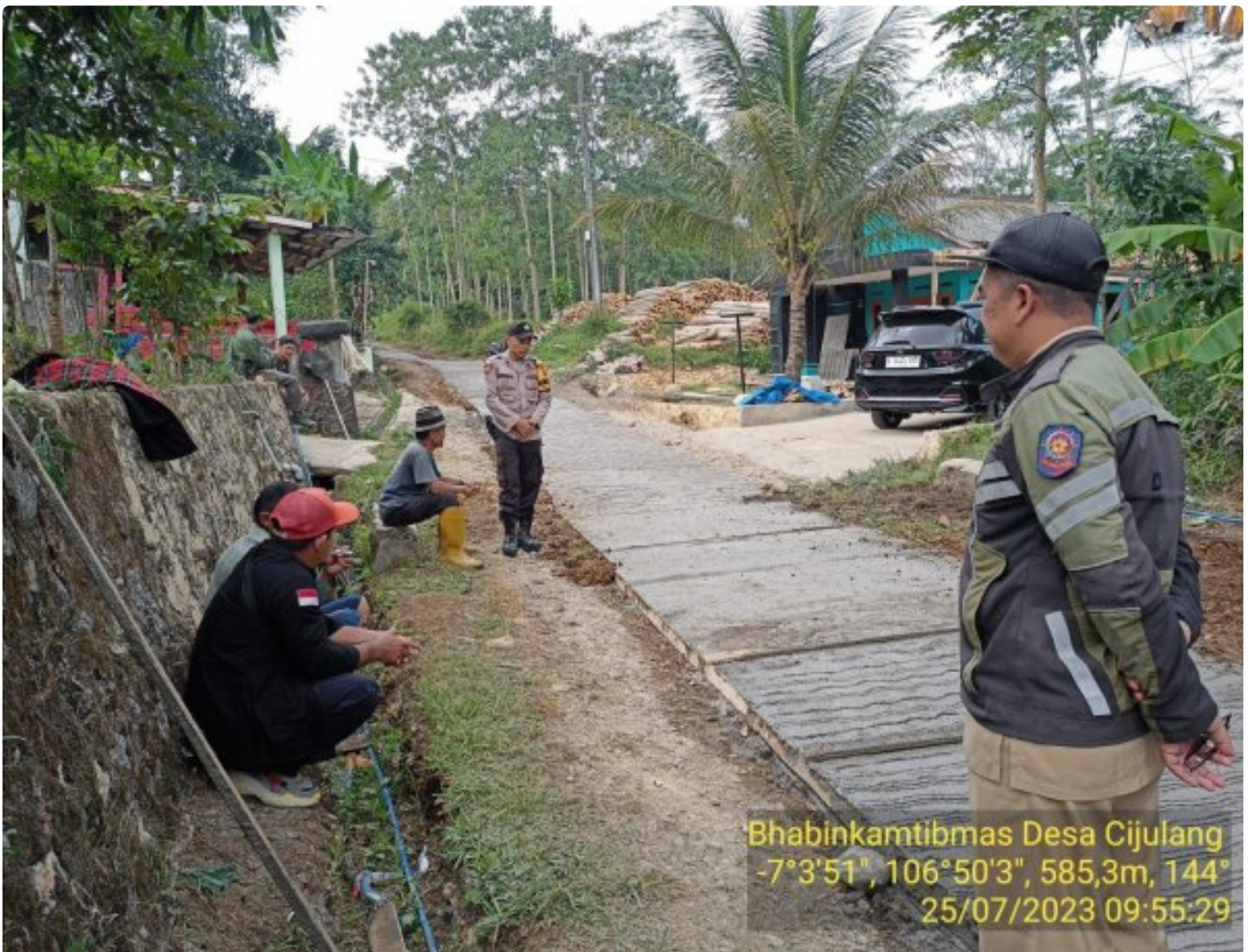
Aipda Sudiro Monitoring Pembangunan MCK di Desa
